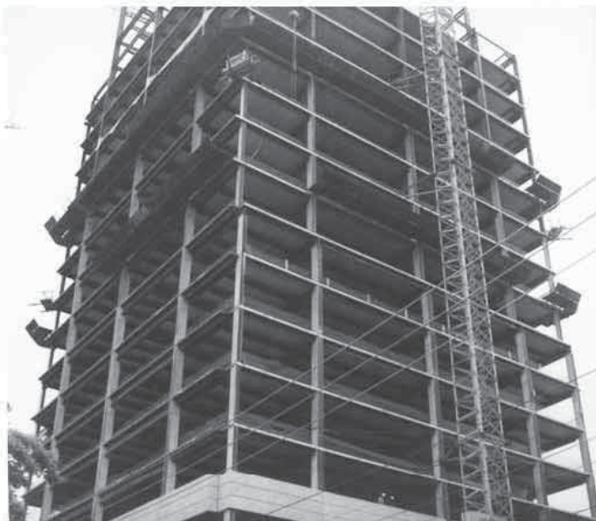
Figura 1.3 – Edifício com pilares mistos parcialmente revestidos.
