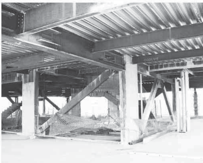
Figura 1.4 – Detalhe de um pilar misto parcialmente revestido.
