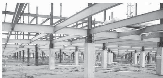
Figura 1.6 – Pilar misto totalmente revestido
